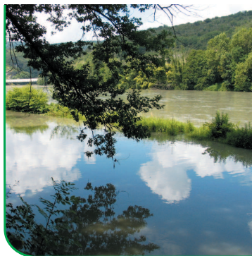
Déflecteur de crue dans le lit du fleuve.
